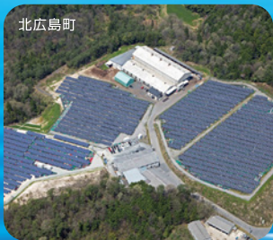
リースキン太陽光発電所
